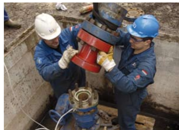
Arbeiter montieren den Bohrkopf
